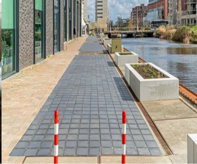
Fußgänger PV Groningen
