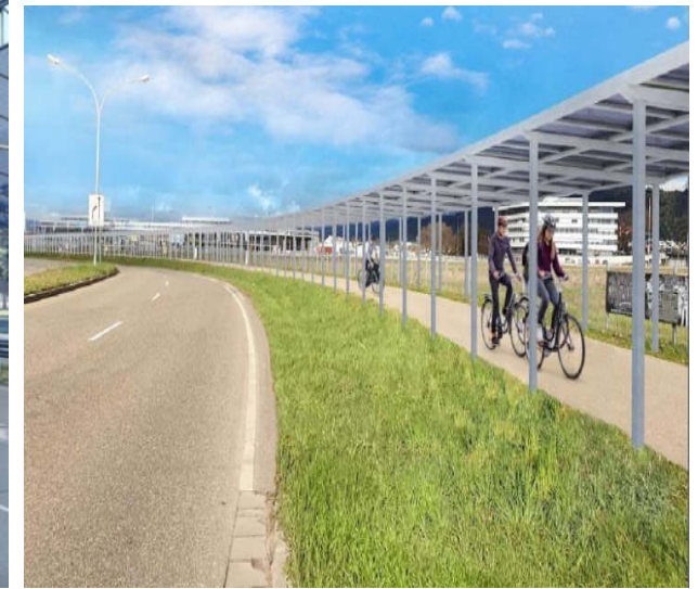
PV Überdachung Radschnellwege Freiburg
