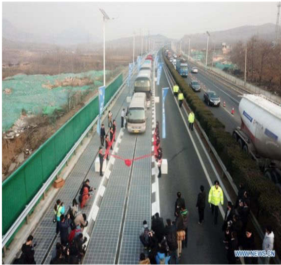
Autobahn PV Straßenbelag China
